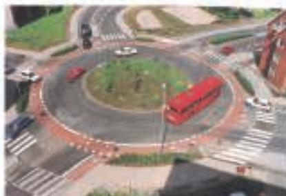
Figura 20 - Un esempio di rotatoria interamente pensata per i ciclisti in quanto la scelta del suo diametro e l'angolo all'interno della corsia pedonale e ciclabile si basa sul miglioramento dell'angolo visuale degli utenti.
