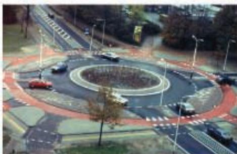
Figura 21 - Un esempio di rotatoria adatta per i ciclisti. In questo la corsia ad essi è destinata il ricavato all'esterno della corsia giratoria, con uno spazio inteso come di fermata per le automobili in entrata e in uscita dalla rotatoria (fonte: European Commission, 1998, Address - Analysis and Development of New Insights into Substitution of Short Car Trips by Cycling and Walking)
