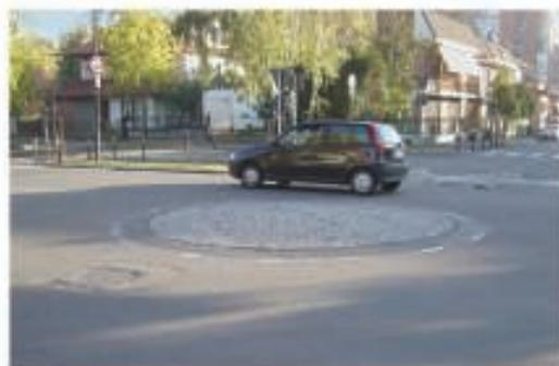
Figura 2 - Una minirotatoria con l'isola centrale completamente asfaltabile
