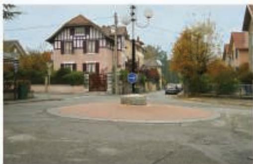
Figura 1 - Una minirotatoria con l'isola centrale parzialmente asfaltabile
