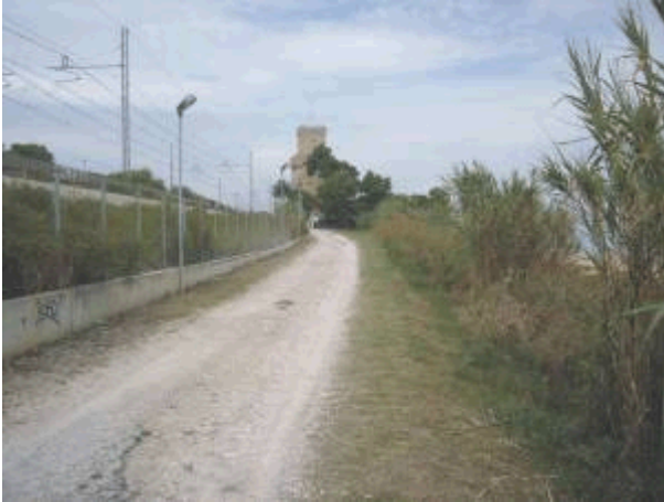
Fig. 23 Stradina che dal sottopasso ferroviario conduce alla Torre
