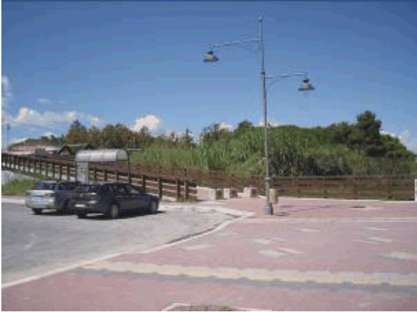
Fig. 35 Ponte sul Torrente Cerrano
