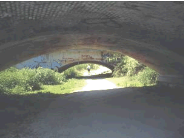
Fig. 37 Sottopasso ponte ferroviario e stradale
